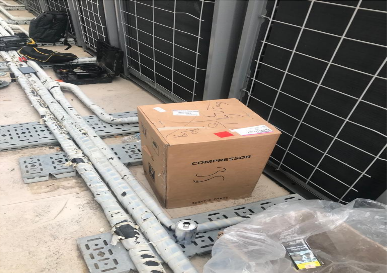
Spor Bilimleri Fakültesi Havalandırma ve Klima Santralleri Bakım ve Onarım İşi
